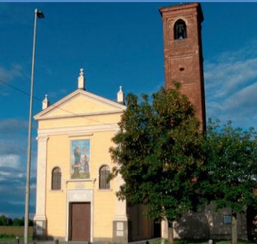
La facciata del Santuario di San Vito dopo i restauri
