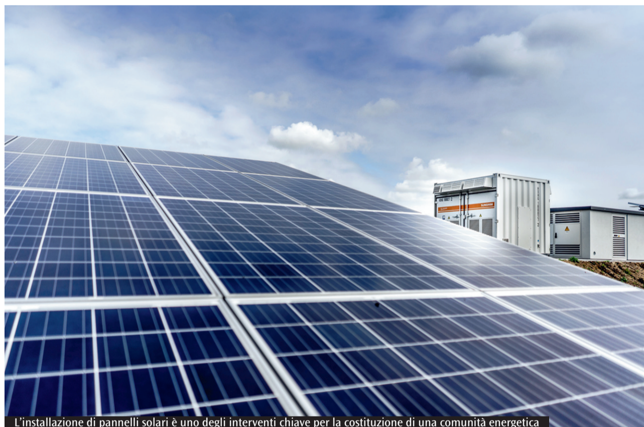
L'installazione di pannelli solari è uno degli interventi chiave per la costituzione di una comunità energetica
