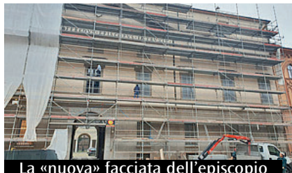
La «nuova» facciata dell'episcopio
