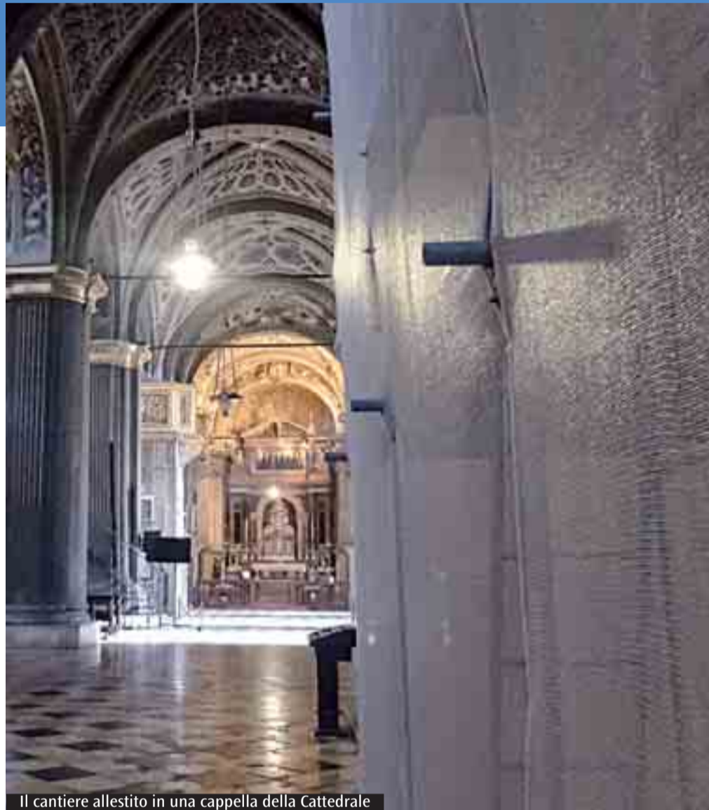
Il cantiere allestito in una cappella della Cattedrale
